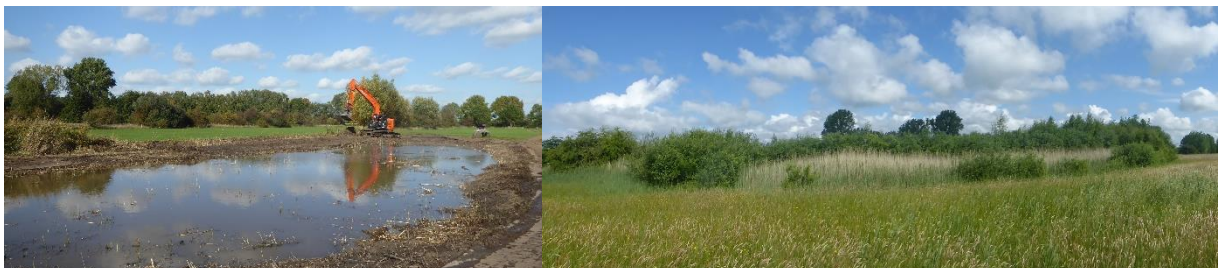
Blänkenentschlammung im Oktober 2022 (rechts Zustand vorher)
