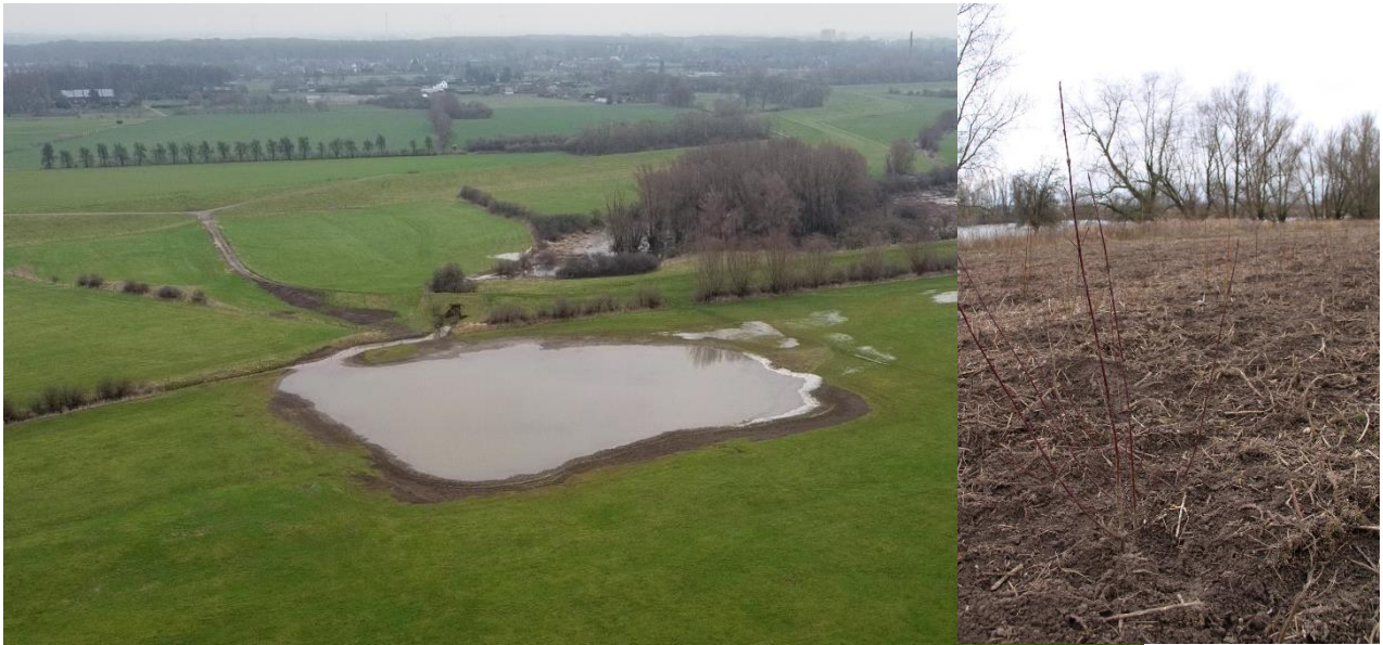
In der ersten Bauphase neu angelegte Flutmulde. Ausgleichspflanzung im Osten des Gebiets
