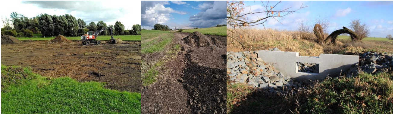
Bauarbeiten im Rahmen des LIFE-Projektes „Feuchtgebiet Emmericher Ward“: Vertiefen von Flutmulden und in den Entwässerungsgraben eingesetztes Betonfundament für einen der drei zukünftigen Stau.
