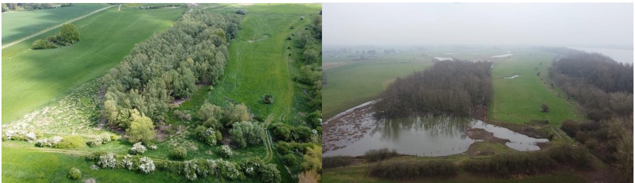
Maßnahmenggebiet Bauphase 2: Gebiet um das Sieltor vor und nach den vorbereitenden Gehölzmaßnahmen (Sommer 2022 und Winter 2022/23)
