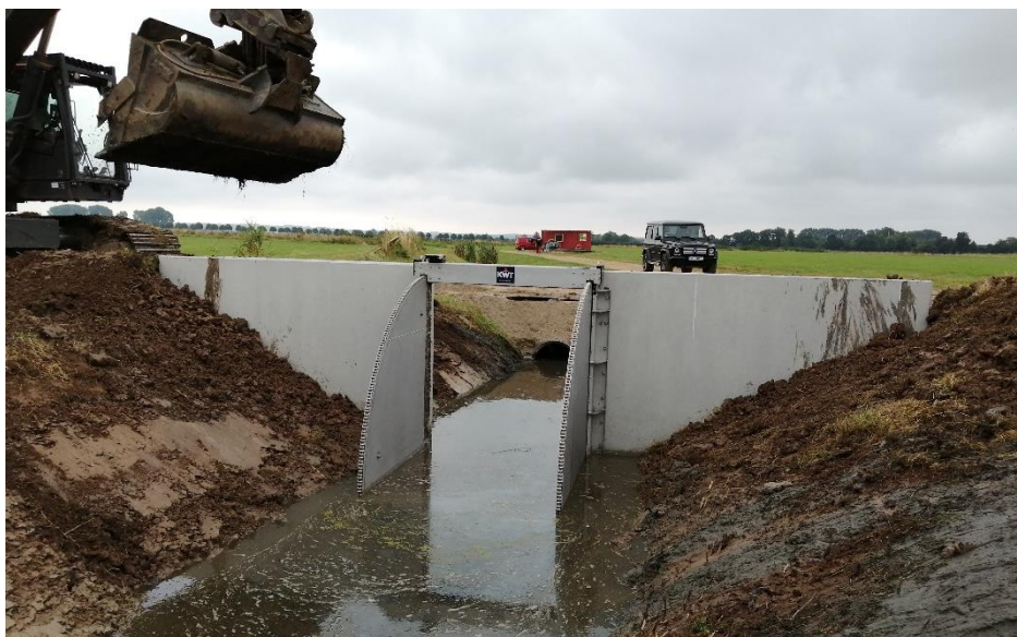
Gerade frisch eingebauter regelbarer Stau in einem der Gräben im NSG Düffel.
