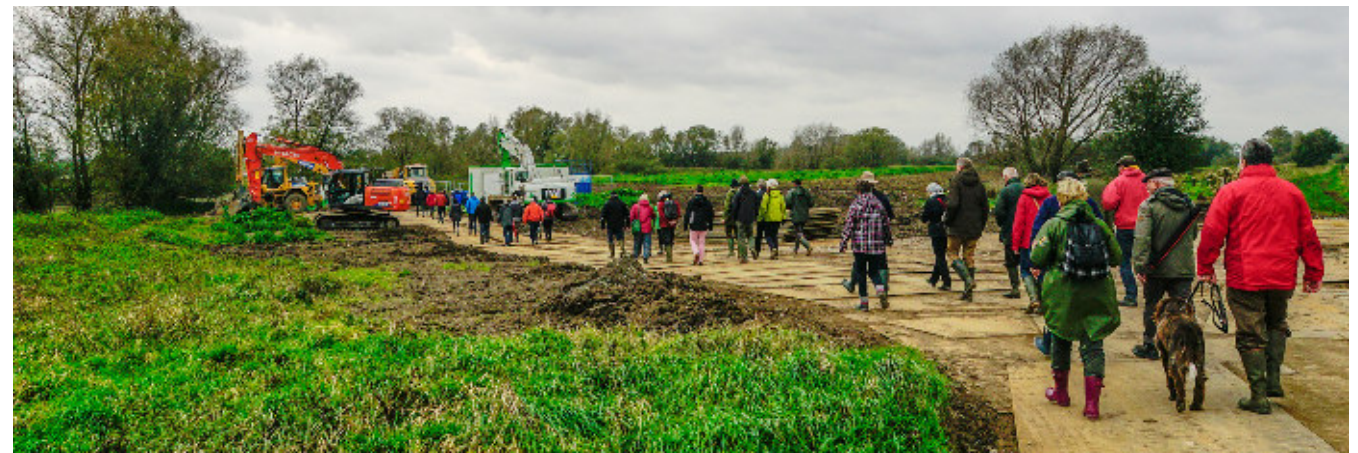
Öffentliche Exkursion zur Baustelle in der Emmericher Ward.
