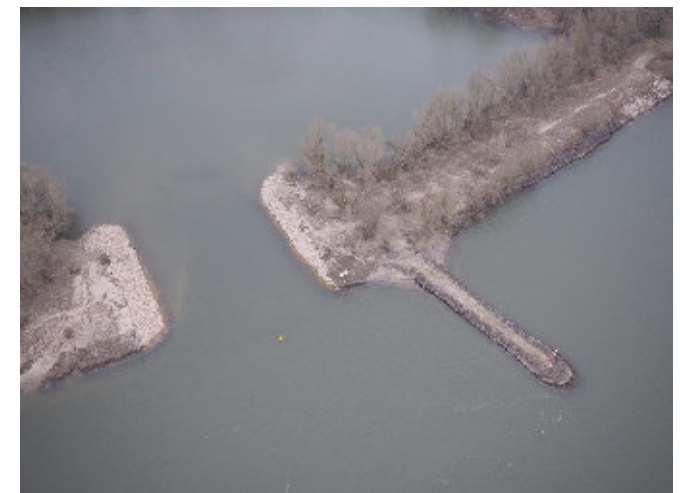
Mit Wasserbausteinen gesicherter Einlaufbereich der Nebenrinne; Sohlbreite 30 Meter.
