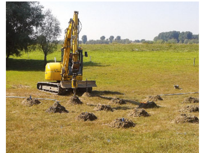
Kampfmitteldetektion vor den Bauarbeiten am Seitenarm.
