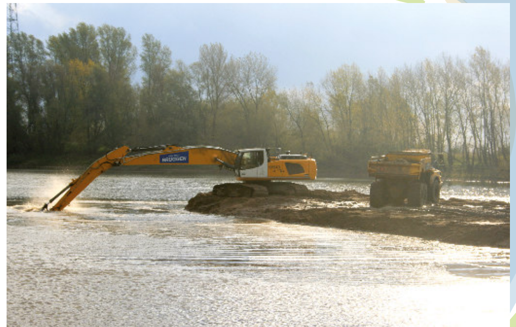
Der größte Teil des Aushubs wird zur Schaffung einer Flachwasserzone im Abgrabungssee verwendet.
