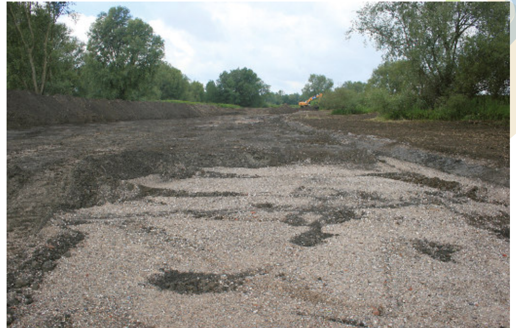
Die verschiedenen Bodenschichten – wie Oberboden, Lehm und Kies – wurden getrennt ausgehoben und größtenteils an anderer Stelle wiederverwendet.
